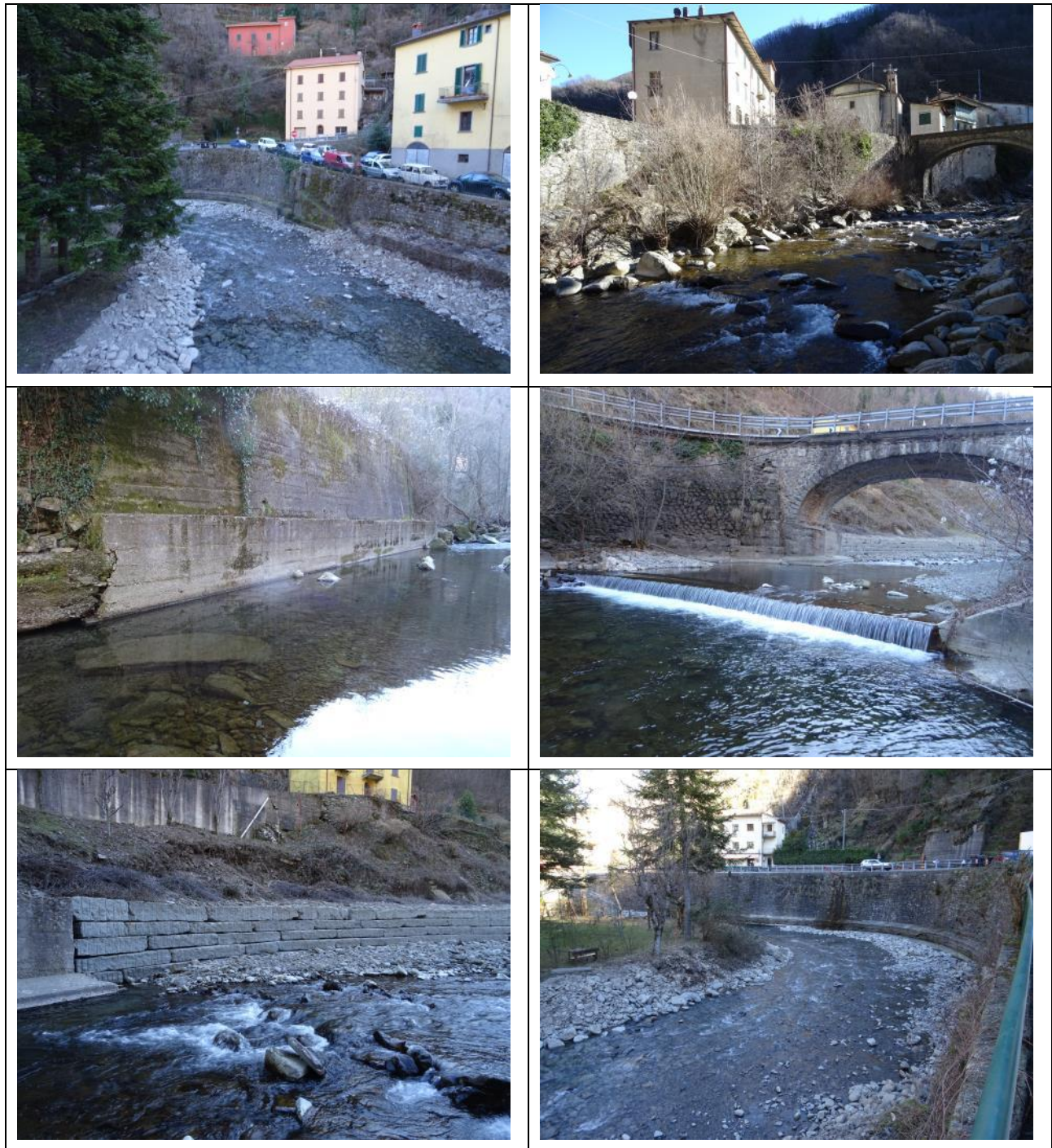
Figura 3-5: difese spondali e attraversamenti
