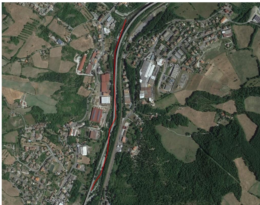
Figura 7-2: tratto rilevato per applicazione IQMM
