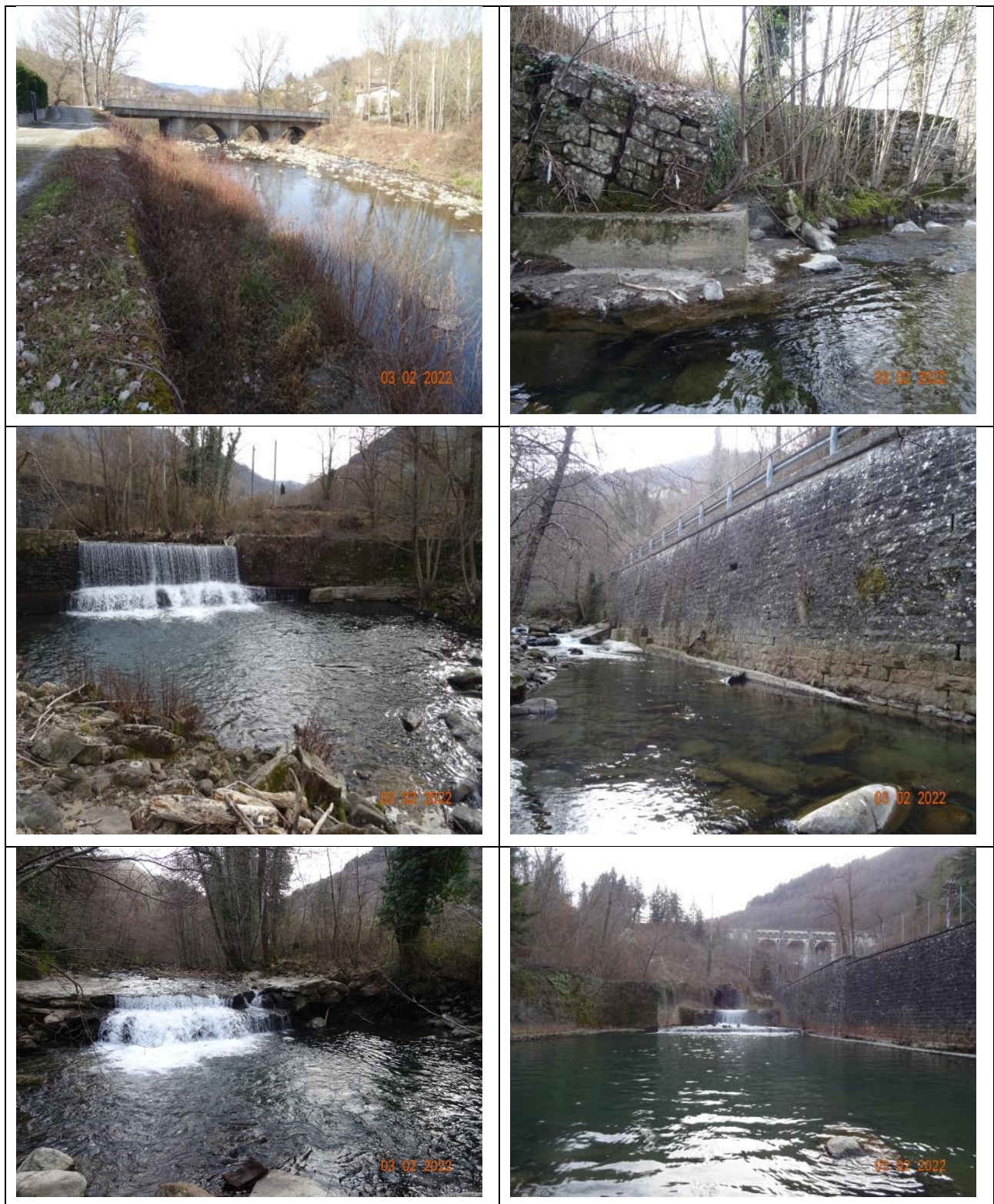
Figura 4-5: difese spondali e attraversamenti
