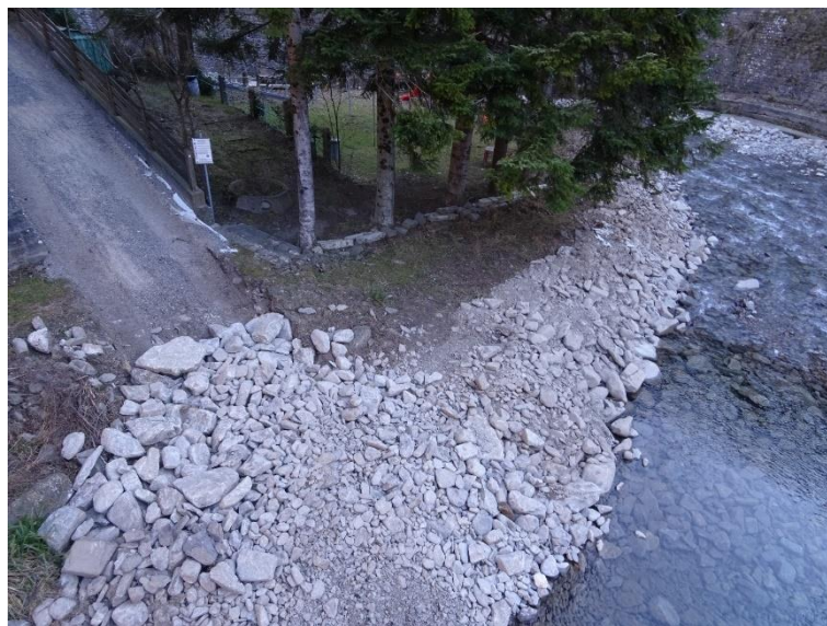
Figura 3-6: rimodellazione sponda sx
