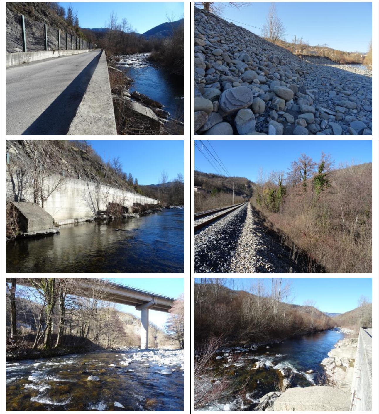
Figura 6-5: difese spondali e attraversamenti
